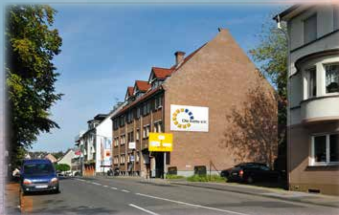
Foto innen und außen v.l.n.r.: © jag_cz -fotolia.com; Gebäude: Tom Weber
